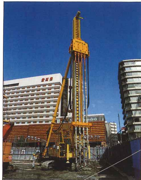
● 4軸機による連続壁施工 Soil-retaining wall work ( 4-SHAFTS )
