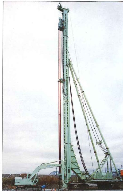
● 2軸機による地盤改良施工 Soil consolidation work ( 2-SHAFTS )
