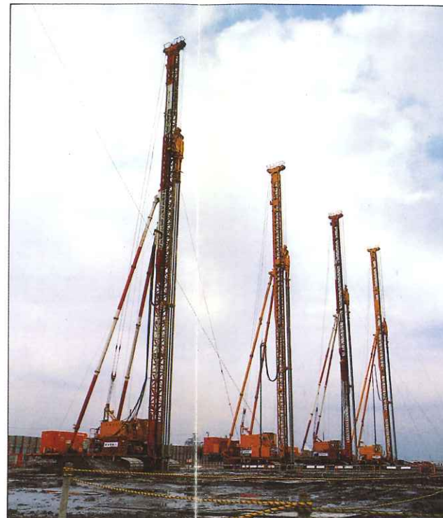
● 2軸機による地盤改良施工 Soil consolidation work ( 2-SHAFTS )
