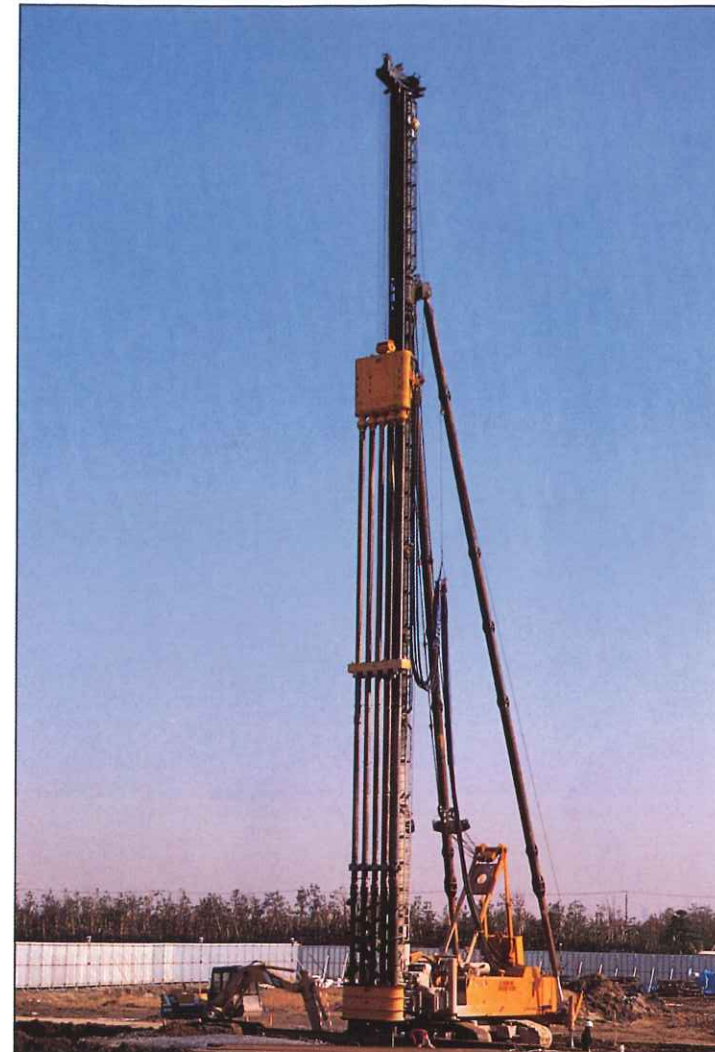
● 5軸機による連続壁施工 Soil-retaining wall work (5-SHAFTS)
